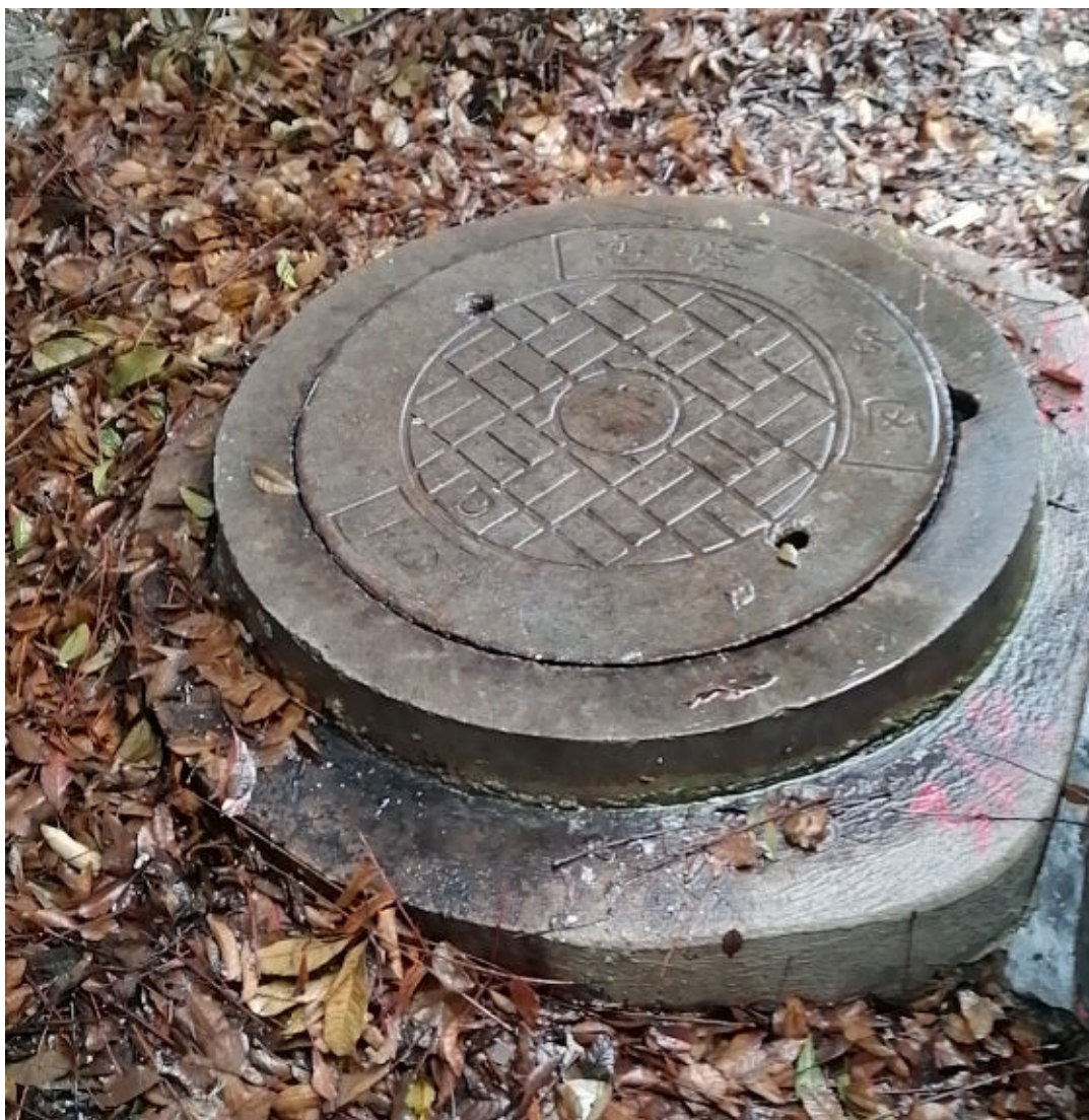
图 3-1 项目污水接管口
