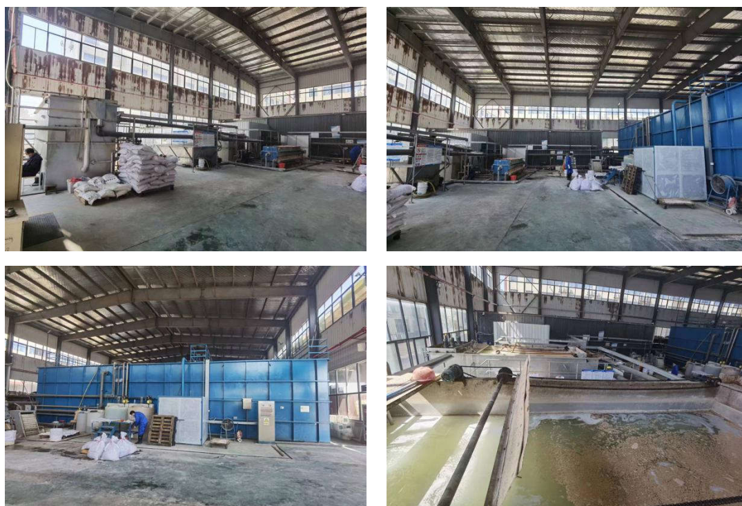
图 3-1 项目污水处理站
