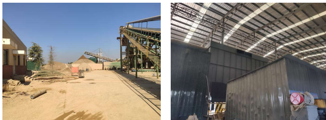
图 3-4 项目一般固废堆场及仓库
