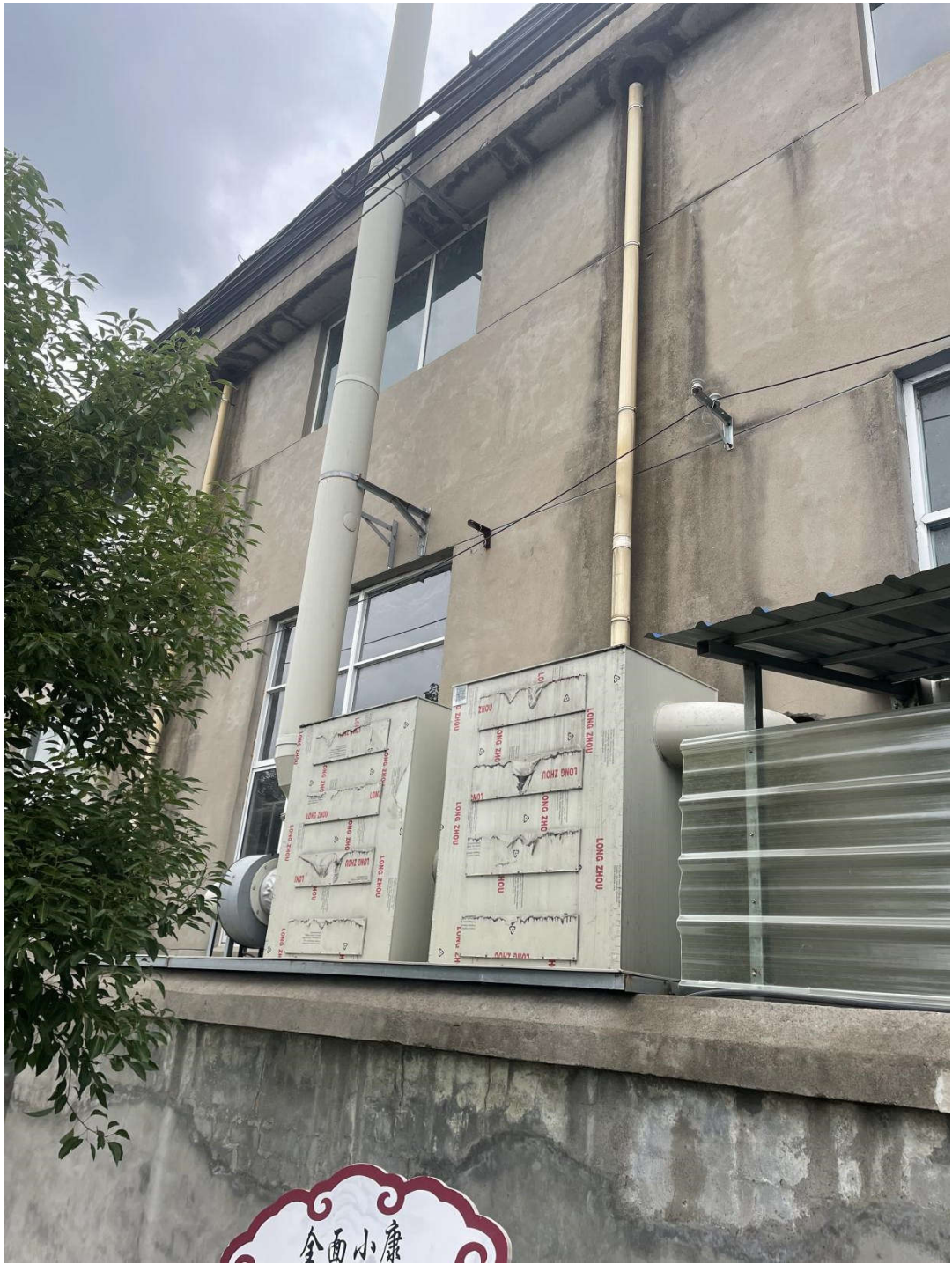
图 3-7 熔融挤出废气处理设施
