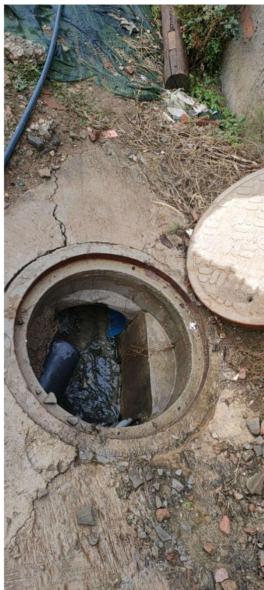
项目雨水接管口
