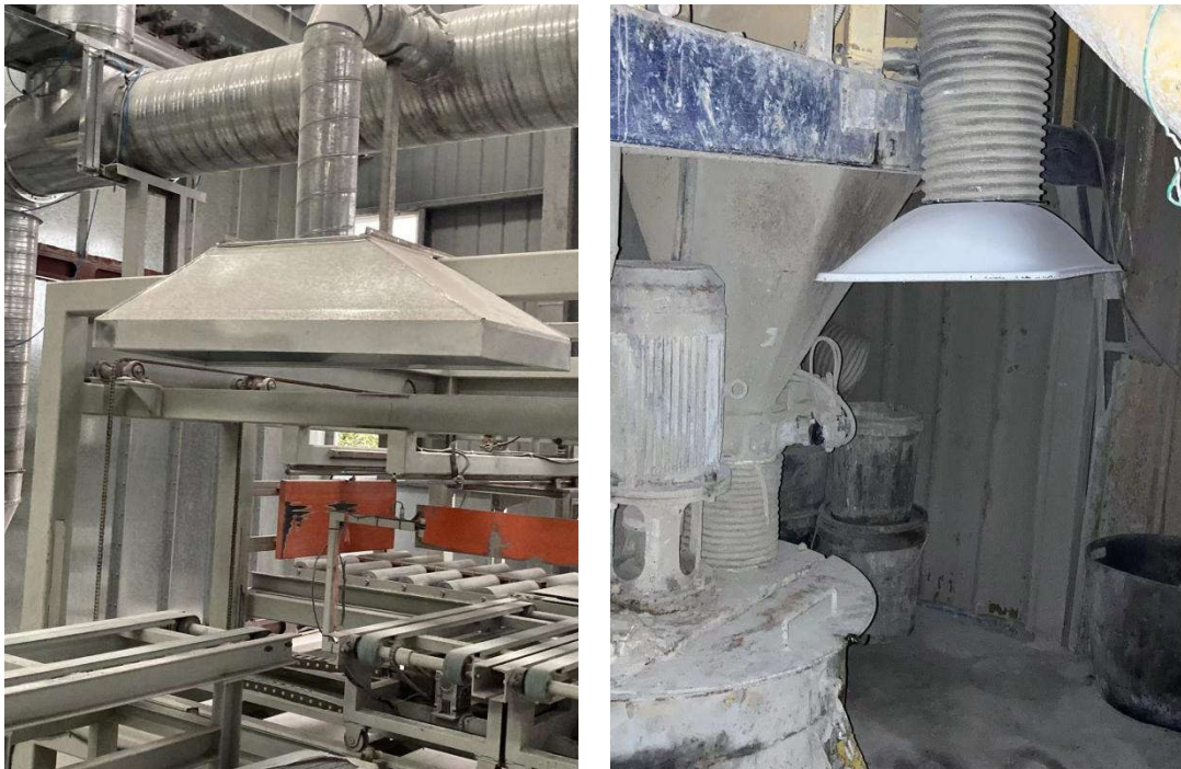
投料废气收集措施
